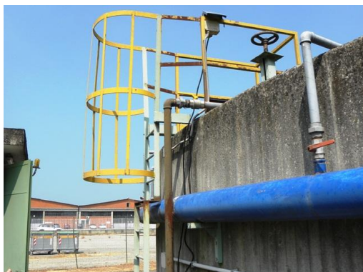
Figura 15 - Scala a pioli accesso stabilizzazione
