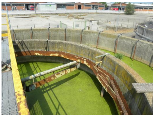
Figura 13 - Sfioro sedimentatore e scum-box
