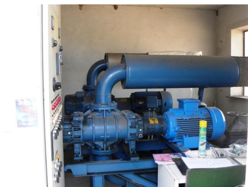
Figura 19 - Compressori di processo
