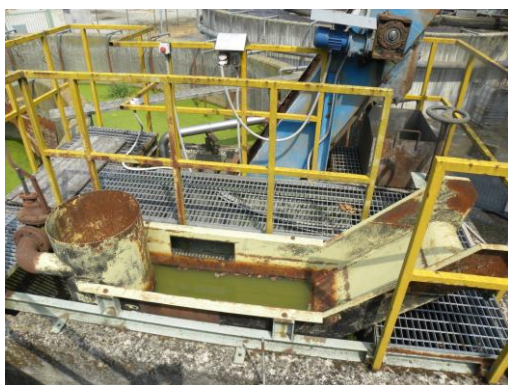
Figura 9 - Dissabbiatura - disoleatura
